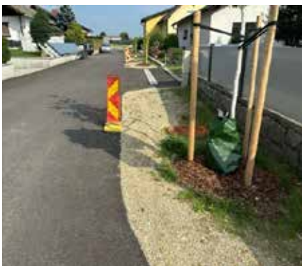
Neue Bauweise in der Wohnstraße Lärchenweg.
