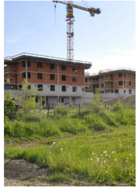
Neue Wohnungen am ehemaligen Molkereigelände
