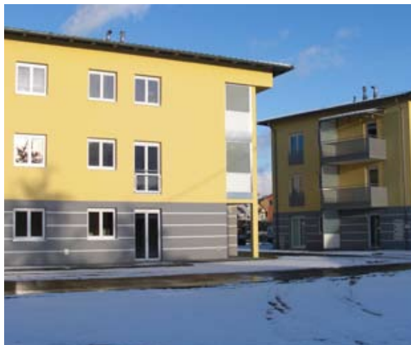
Neu errichtete Wohnbauten am Ziegeleigelände.
