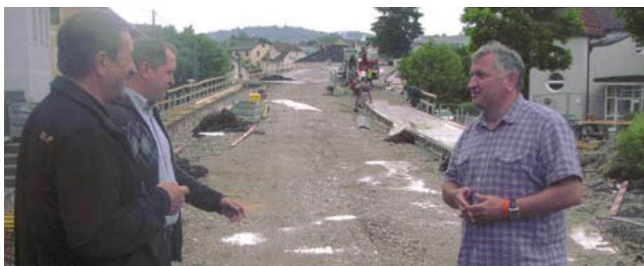
Vbgm. Manfred Wurm, Parteibmann Alexander Skrzipek und StR Roman Mayrhofer beim Brückenbau.
