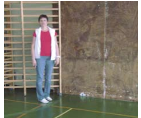
Die Turnhalle ist in einem desolaten Zustand.
